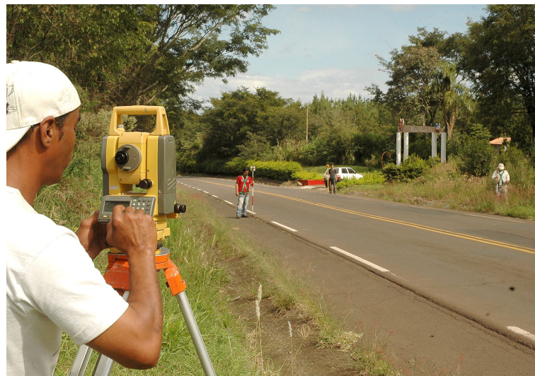
Início de obras na rodovia SC-468, em Formosa do Sul, no Extremo-Oeste
